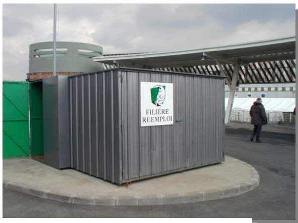
Stockage tampon déchèterie
