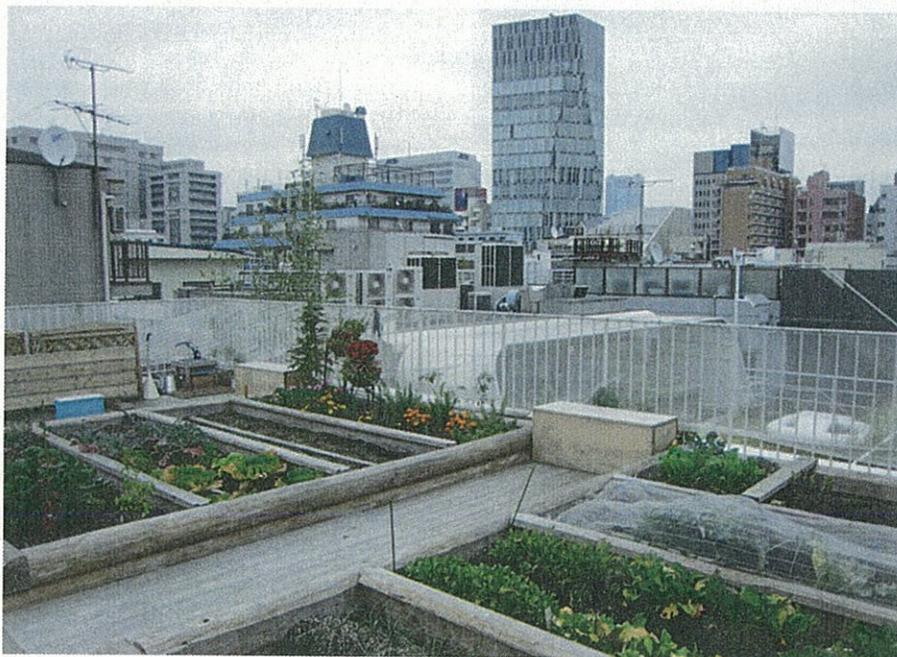
hydroponique de patates douces sur la toiture d'un bâtiment situé en plein cœur de Tokyo. D'après ses mesures, ce Sweet Potato Roof fait descendre la température de la toiture de 27°C aux heures les plus chaudes de la journée.
