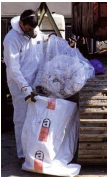
Les opérations de désamiantage nécessitent des protections adéquates.
