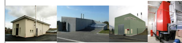
Fonctionnement des chaufferies
